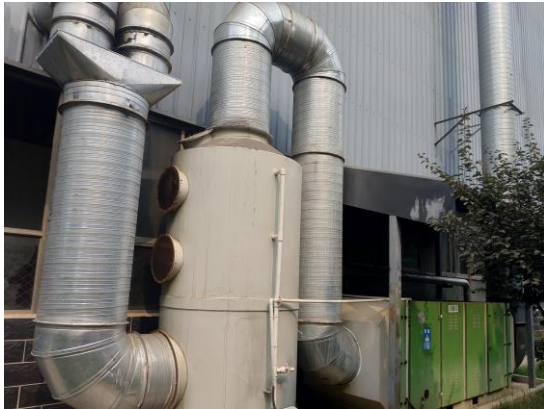
水喷淋加过滤棉加 UV 光氧催化装置
